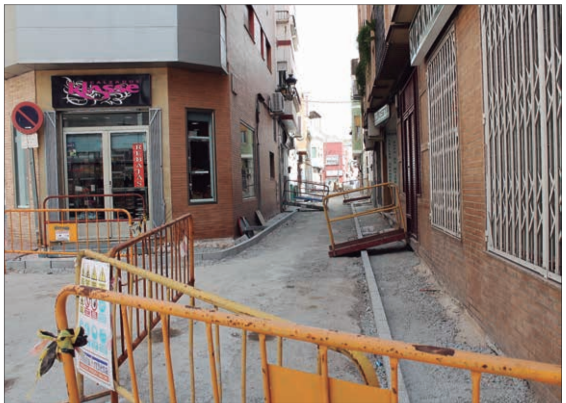
UNA IMAGEN DE LAS OBRAS DE ESTA CÉNTRICA CALLE DE ARCHENA
