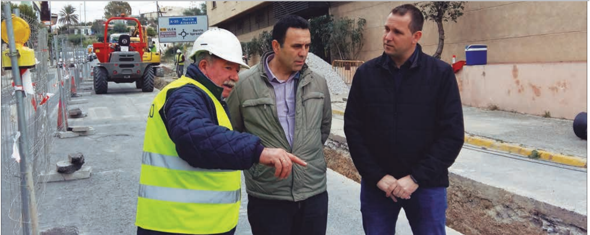
EN LA IMAGEN, UN MOMENTO DE LA VISITA DE LOS EDILES MUNICIPALES A LAS OBRAS QUE CUENTAN CON UN PRESUPUESTO DE 240.000 EUROS
