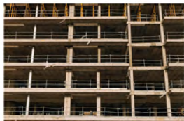
Estructuras de Hormigón
